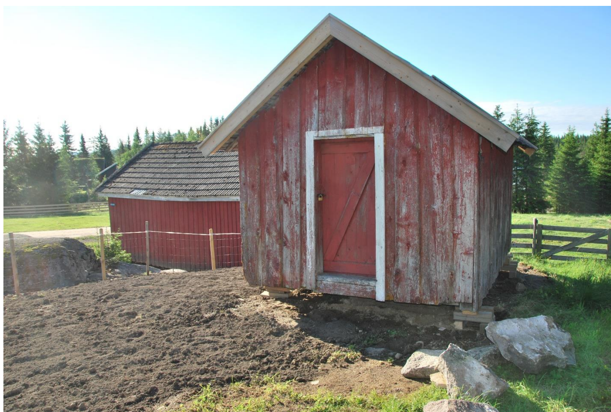
Stabburet på Sagvollen får nytt liv. Arbeidet utført av Olav Løvhaug. Foto Harald Kvam
