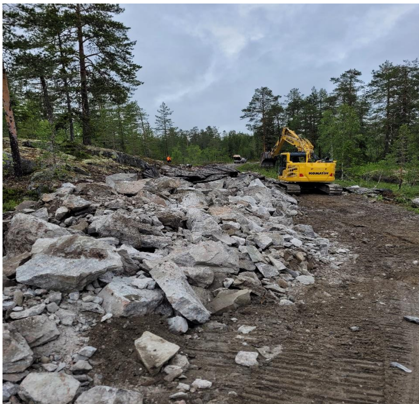
Skyting av vegggrøfter på Otermyrbakkvegen. Foto: Harald Kvam
