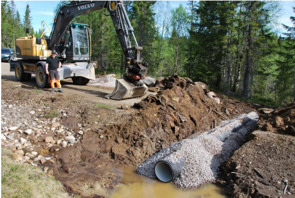
Legging av stikkrenner langs Kvernsjøvegen. Foto: Harald Kvam
