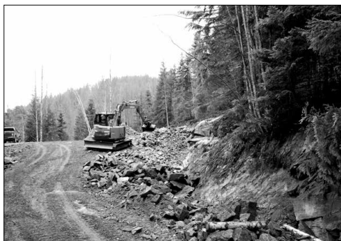
Utbedring av snuplass på Storkleivavegen. Foto Harald Kvam.
